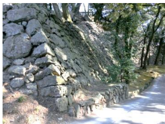
高さ8mにもなる“高石垣” 長さも40mにわたって続く
