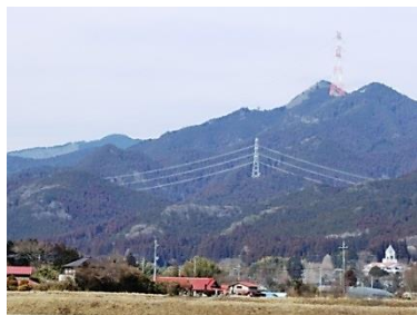
送電線の鉄塔が目立つ鳴蟲山
