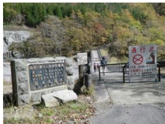
堰堤の一基が 通れるようになっている 渡った向こう側が登山口
