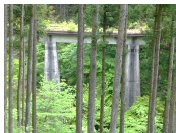
コンクリート橋の遺構↑
